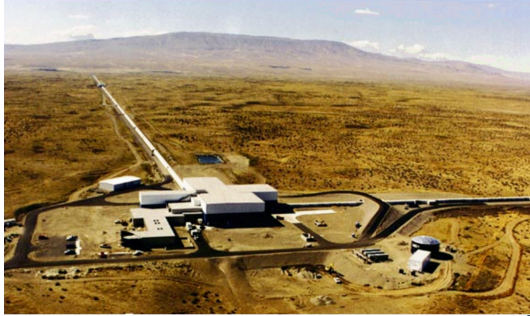
LIGO Hanford WA (4km & 2km)
