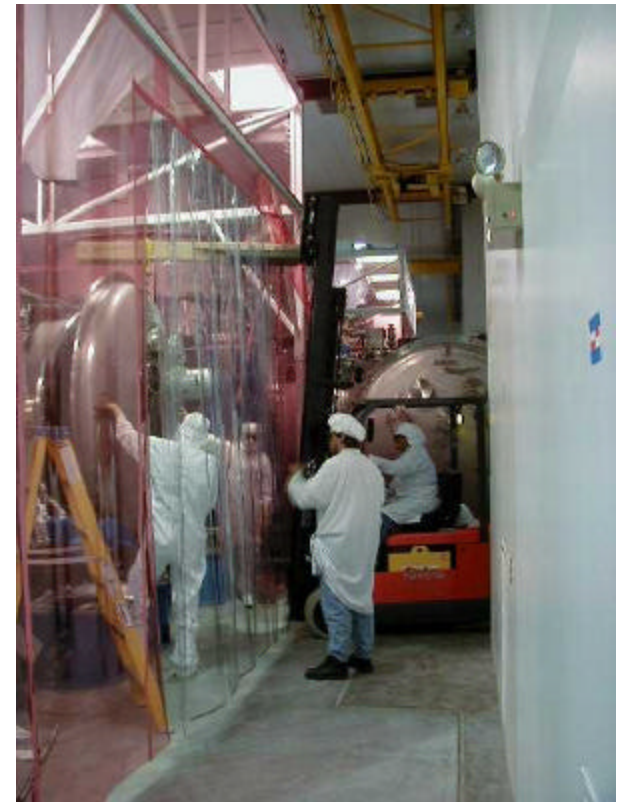
HAM Door Removal (Hanford 4km)
